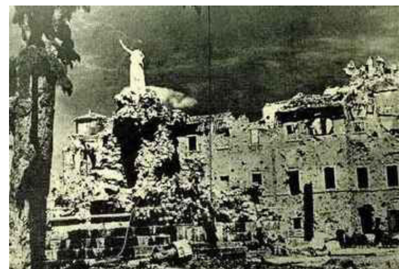
La Fontana Biondi gravemente danneggiata
